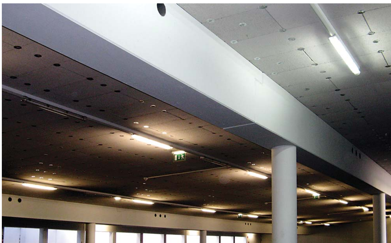
3i - stropní izolační desky dodatečná montáž hmoždinami
